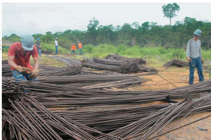
Construção de ponte na BR-364, em Rondônia. Obras de infra-estrutura do PAC devem impulsionar construção civil este ano, aponta pesquisa do Sinduscon-SP
